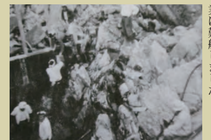
幌満川で作業にあたる作業員。硬い岩盤に阻まれ、作業は難航しました。
