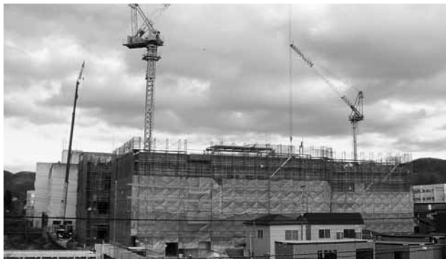
◀ 改築工事が始まった 浦河赤十字病院
