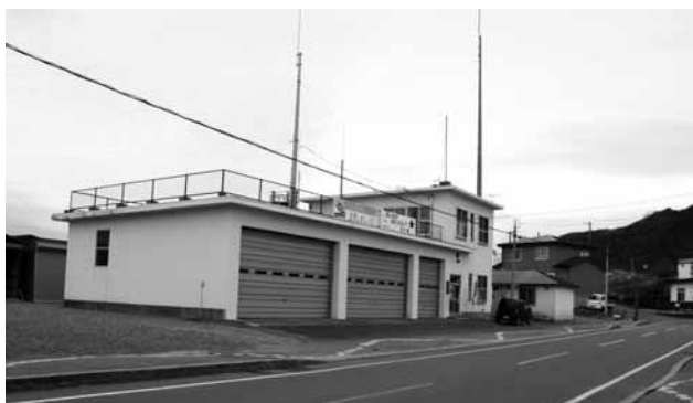
▲改築が計画される消防庁舎
