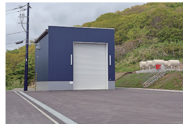
<西町高台に建設した消防エネルギーセンター>
