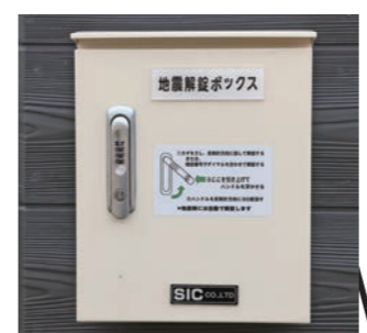
↑ドア横のキーボックス。震度5弱以上の揺れを感知し、自動的に解錠されます。
