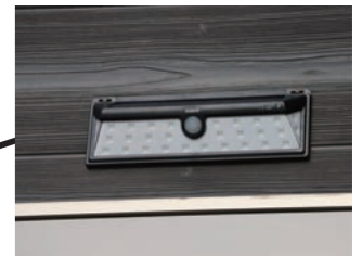
↑夜間の避難に備えて、人感センサー付きライトを取り付けています。
