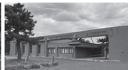
【西町生活館(玄関ホール内)】
