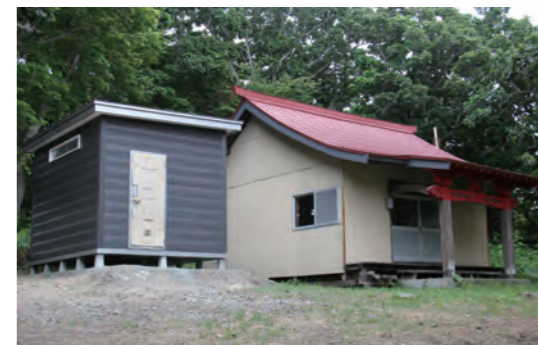
平宇神社境内に建設中の防災備蓄庫
