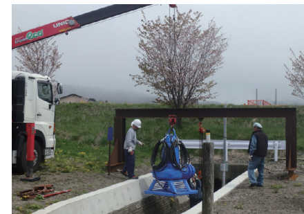
オコタヌシ川 水中ポンプ設置
