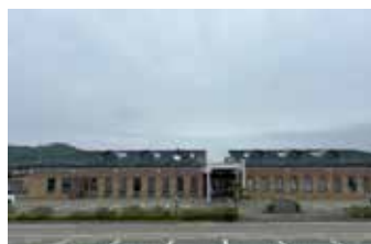
エアコン等改修予定の保健センター
