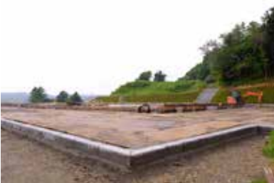
様似消防支署建設工事現場
