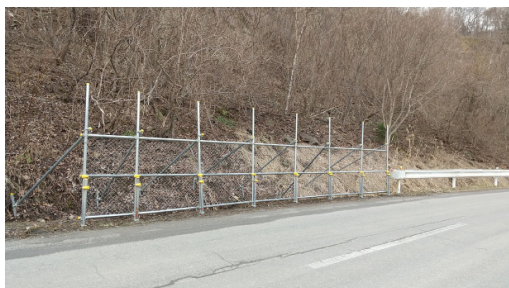
▲ 設置済みのフェンス
