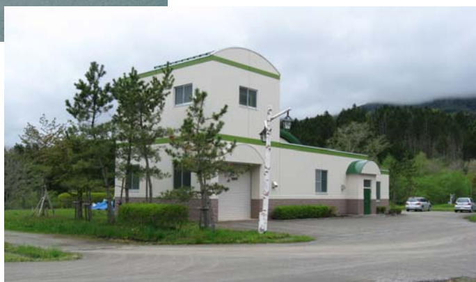
写真 2-6-1 最終処分場（埋立処分地・浸出水処理施設）
